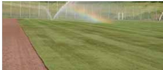
Umgehende Wässerung direkt nach der Verlegung
