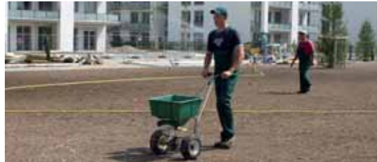
Ausbringung von Starterdünger vor der Verlegung
